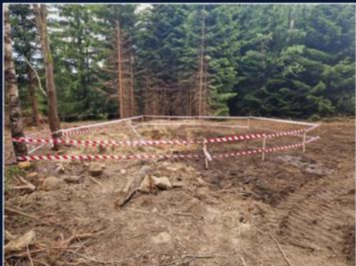
Zajištění sanačního vykopu bezpečnostní páskou.
