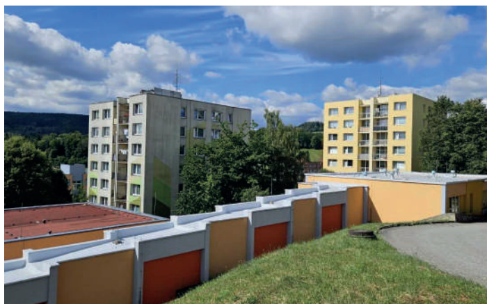
Jednou z letních investic na školách byla oprava střechy na hospodářské budově a spojovací chodbě mateřské školy v Mírové ulici.
