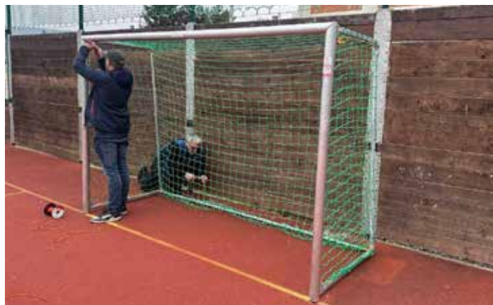
Dne 15. dubna byly na sportovním hřišti v Mírové ulici nainstalovány nové branky – robustnější než předchozí, které byly opakovaně poškozovány neurvalým či vandalským chováním. Ať slouží dlouho!
