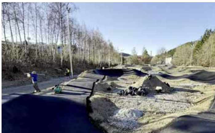
Práce na novém vimperském pumptracku úspěšně pokračují – od 7. dubna se začaly asfaltovat povrchy obou již vymodelovaných boulovatých drah. Celý areál včetně příjezdové cesty, bude dokončen v červnu. Foto Jedemlesem, s. r. o.
