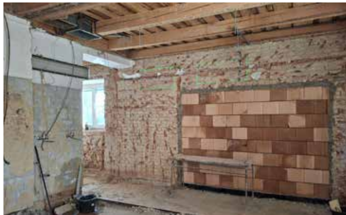
Školní restaurace sv. Rafael prochází modernizací – více na str. 13.
