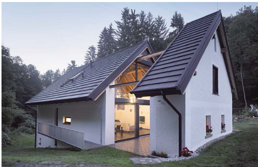
Krytina SATJAM Šindel imitující šindelovou střechu na zrekonstruovaném mlýně, autor stavby: Stempel & Tesař architekti
