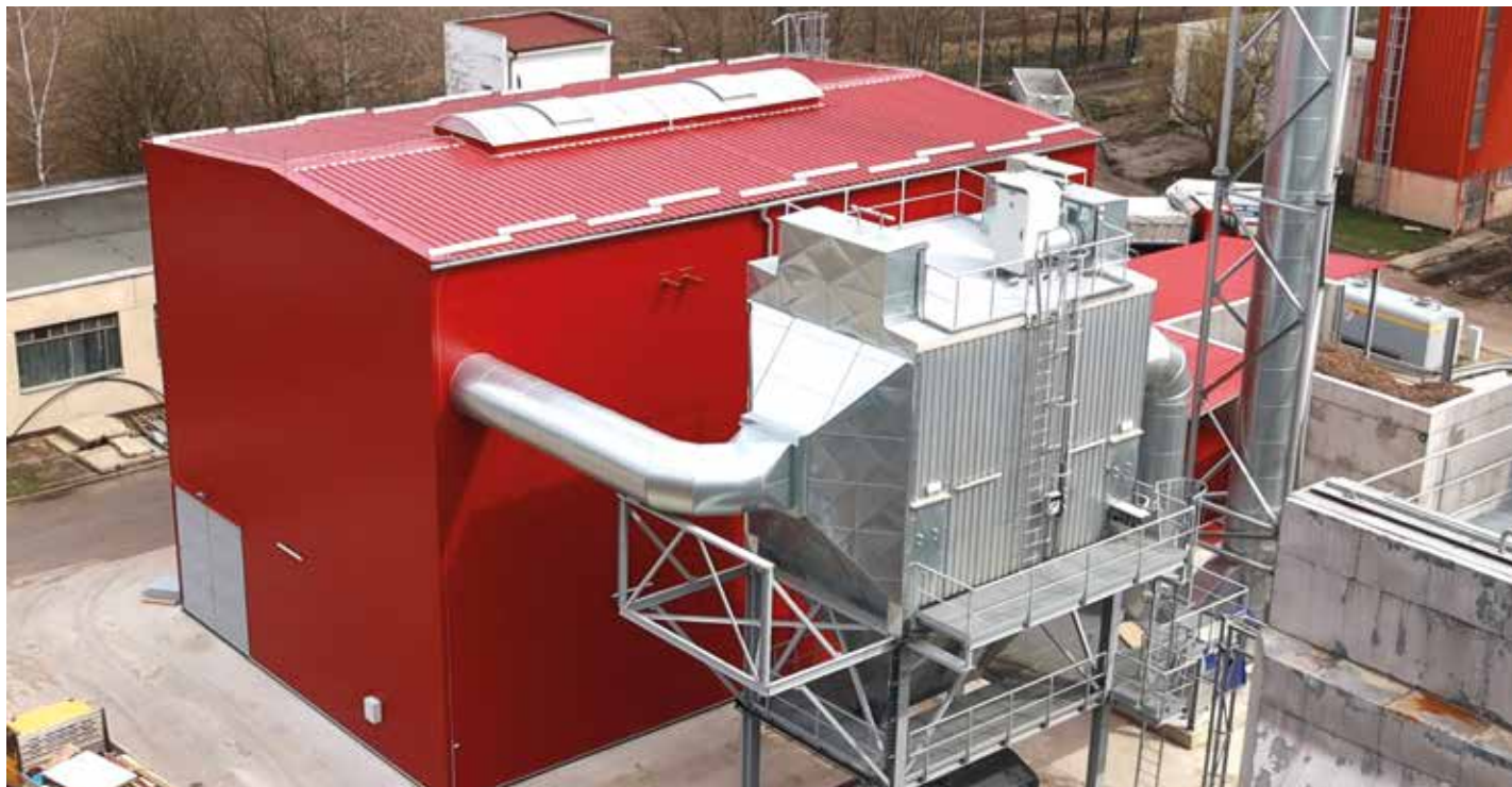
Kotel na biomasu postavila teplárna před několika lety.
