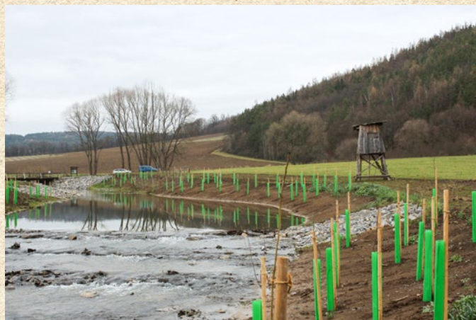
Úpravy koryta formou kamenných pásů umožňující migraci ryb
