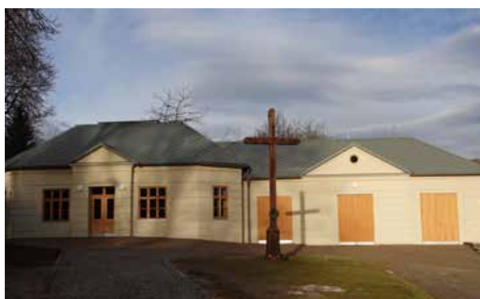
Nová pietní síň byla dokončena v prosinci. Po kolaudaci začne sloužit veřejnosti, pravděpodobně od března.
