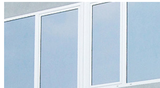
výplně otvorů - hliníkové rámy hliníkové rámy oken a dveří (výplně dveří) v provedení stříbrný elox vizuální podobnost kovového obkladu a rámu oken
