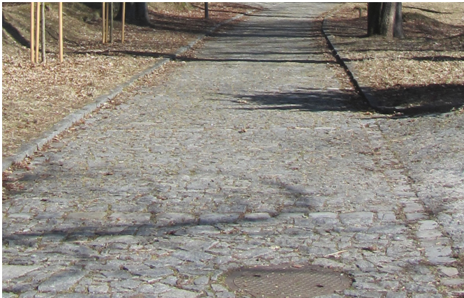
odseková dlažba do pravidelných rámu (větší formát)
