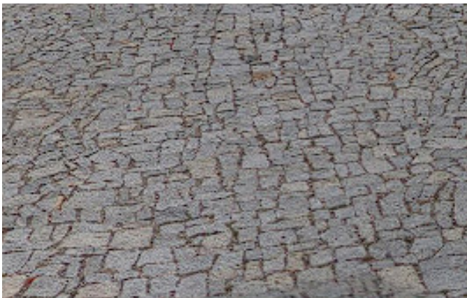
odseková dlažba bez rastru rámu (tmavší barevnost)
