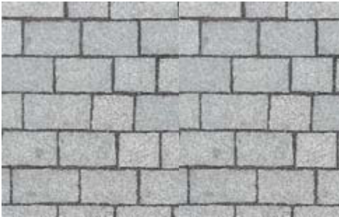
žulová kostka 16/16, běhounová vazba nová - minimalizace širokých spár ve stycích kostek
