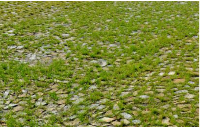
odseková dlažba širokospárá zatravňovací
