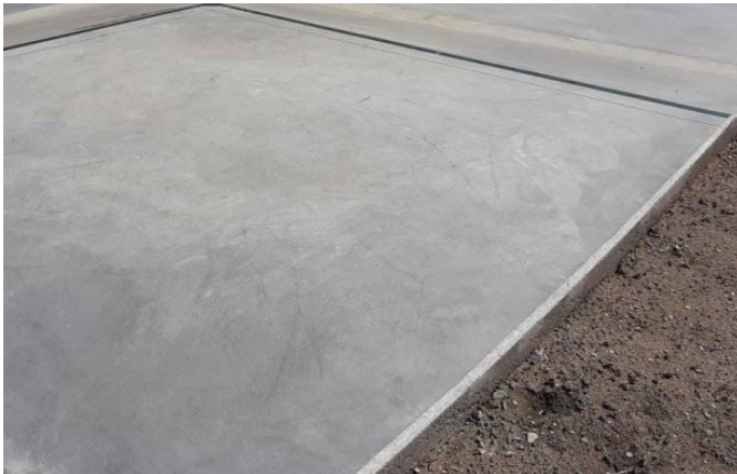
hladký monolitický beton bez dilatačních spár v ploše pódia
