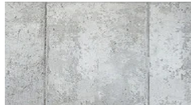
fasáda vstupního objektu - pohledový beton objekt celý odlit z betonu použité hladké bednění do betonářské překližky akcentem nápis „LETNÍ SCÉNA“ a logo odlité do betonu
