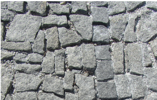
odseková dlažba do pravidelných rámu, malý formát (s barevným kontrastem)
