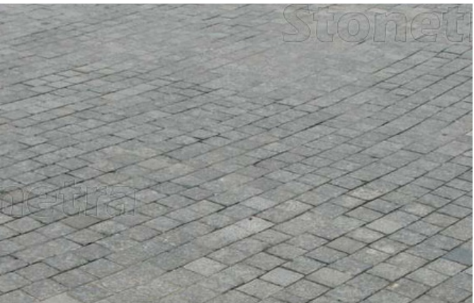
žulová kostka řezaná 10/10, běhounový klad světlá barevnost
