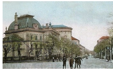
Pohled od ulice Na Florenci
