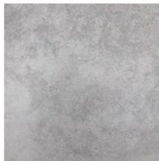
beton podlaha, stěny, stropy, schodiště
