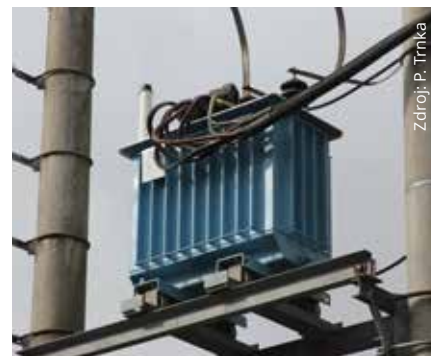
Transformátor s kapalinou ENVITRAFOL v ostrém provozu
