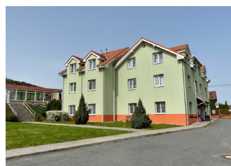
Objekt čp. 14 po rekonstrukci
