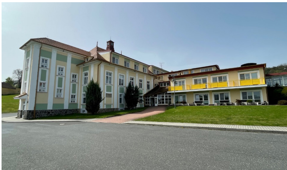
Hlavní budova (objekt čp. 1) po rekonstrukci v roce 2001/2002
