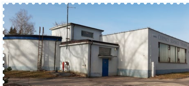
Vodojem Na Kopečku
