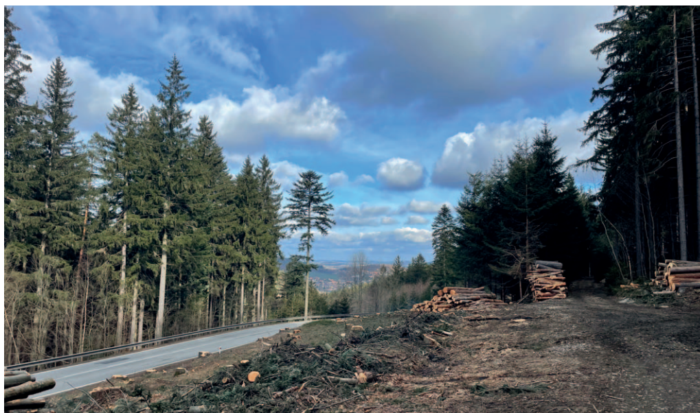
Odtěžení lesa pro rozšíření silnice Prachatice – Libínské Sedlo dokončily Městské lesy Prachatice v polovině února.
