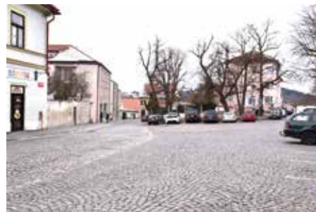
Oprava povrchu v Gregorově ulici naváže na práce realizované v minulém roce.
