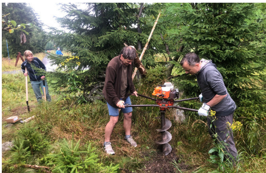
Členové spolku při stavbě zábran proti vjezdu sněžných skútrů na tetřívčí centra. Foto Robin Böhnisch
