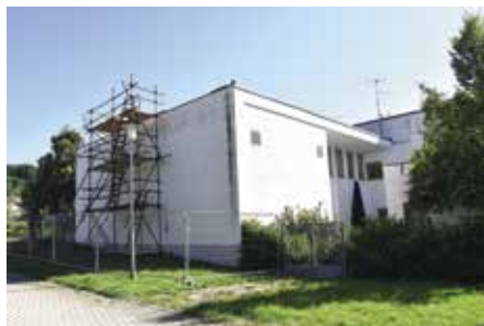
Práce na střeše probíhaly za plného provozu
