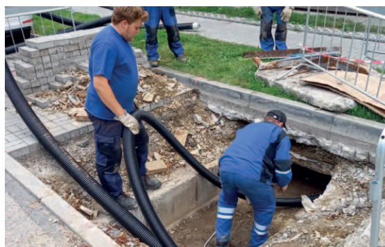
Výměna potrubí Na Sadech.
