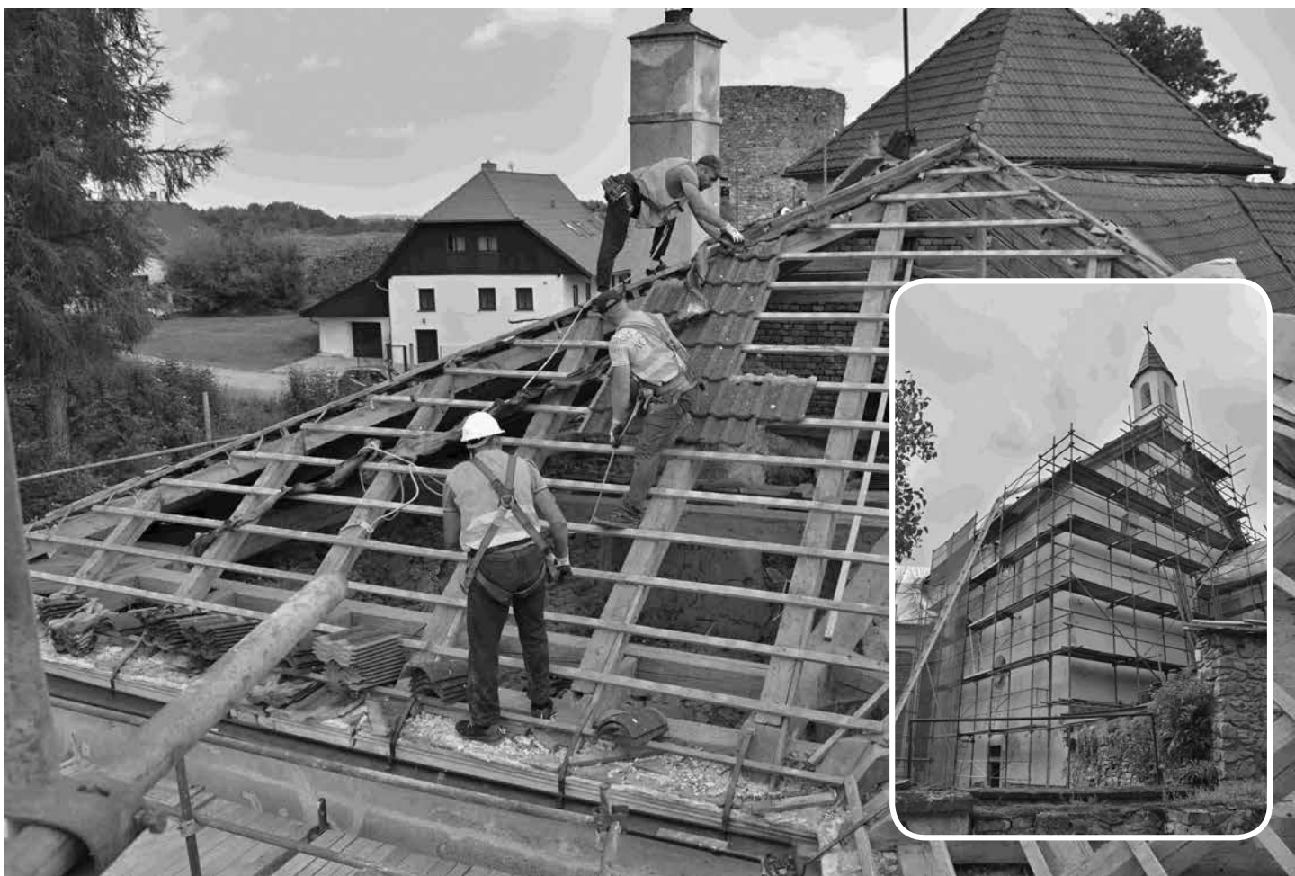
Po celé prázdniny pokračovala okromě opravy střech na Horním zámku i obnova fasád.
