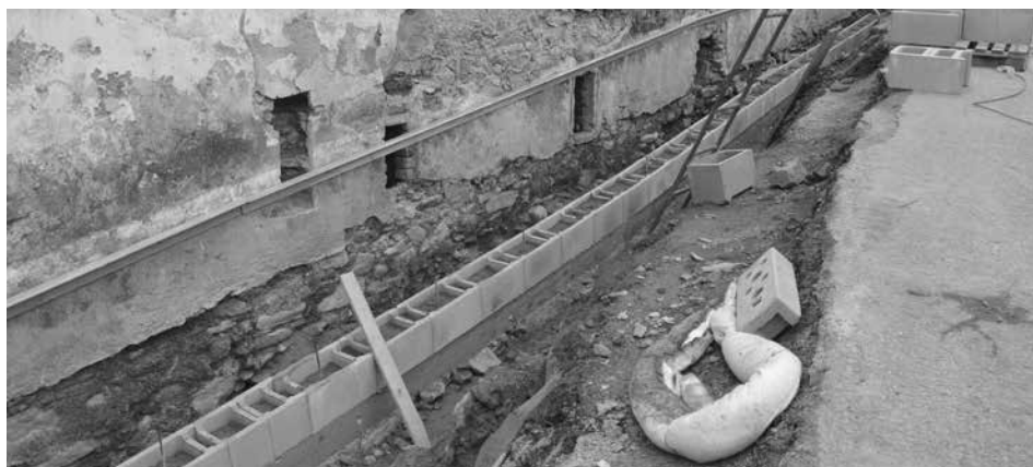
Odvodnění severního křídla Dolního zámku s viditelnými okénky, která dříve byla nad úroveň terénu.
