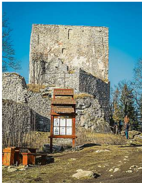
VÍTKŮV HRÁDEK JE ZAPADLÝ V LESE NEDALEKO LIPNA.
