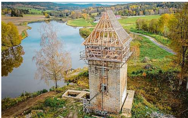
Takto vypadala tvrz Tichá zhruba před třemi lety. Spolek Hradů na Malší areál opravoval celkem čtrnáct let.
