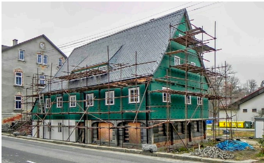
Historický podstávkový dům č.p. 424 v Lipové u Šluknova v průběhu rekonstrukce, která byla i energetickou optimalizací. Zdroj: cottage.cz
