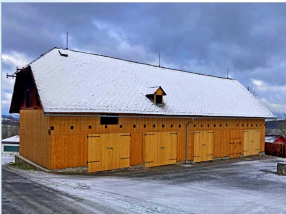
Opravená stodola ve Smetanově ulici
