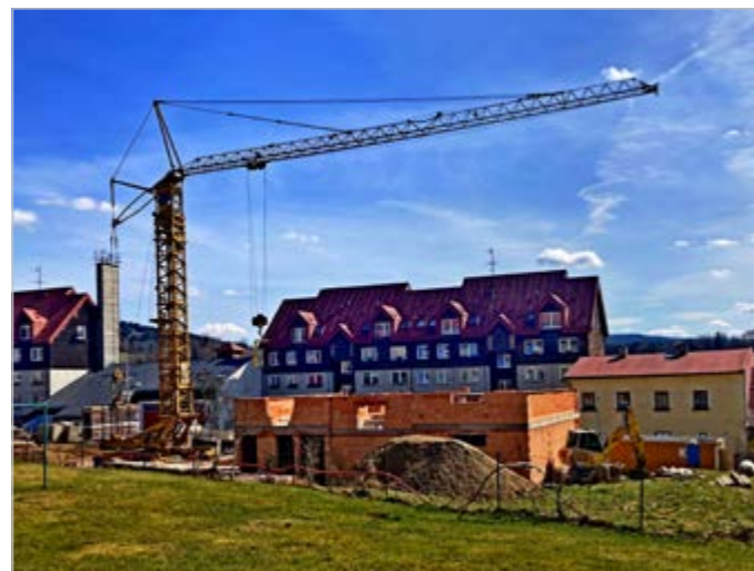
Průběh výstavby bytových domů v Besední ulici
