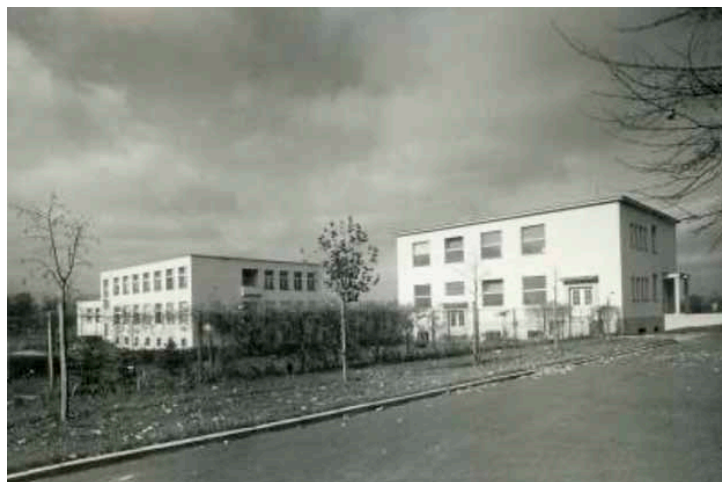
Nová budova patologie vybudovaná ve 30. letech 20. století
