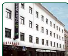
eFi Palace Hotel, Brno, dokončené 2 etapy
