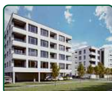
Bytové domy Břeclav, ul. Charvátská
