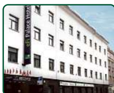
eFi Palace Hotel, Brno, dokončené 2 etapy
