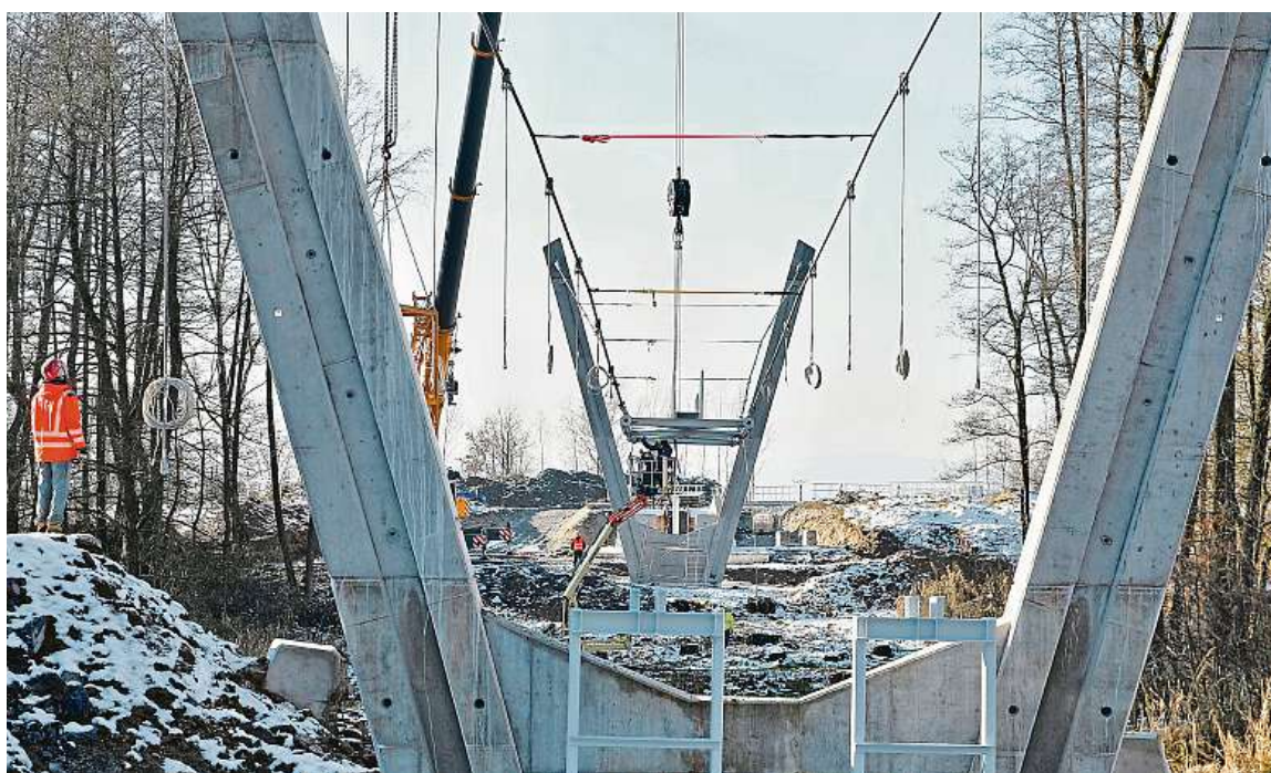
Přes sto metrů dlouhý visutý most pomůže horkovodnímu potrubí z Jaderné elektrárny Temelín překonat přírodní bariéru mezi rybníky Pěnský a Křivonoska nedaleko Hluboké nad Vltavou. FOTO | PETR LUNDÁK, MAFRA
