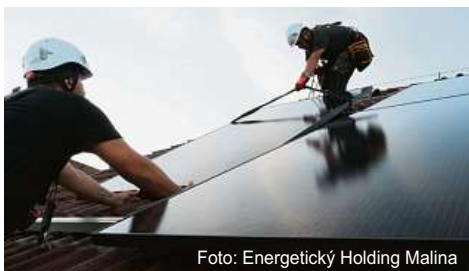
Foto: Energetický Holding Malina
