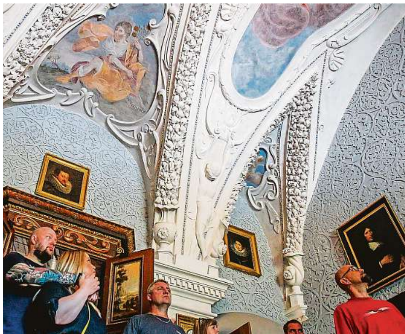
Na zámku v Červené Lhotě zrekonstruovali podle dobových metod i s pomocí tehdejších materiálů štukový strop v jídelně.
