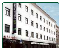
eFi Palace Hotel, Brno, dokončené 2 etapy
