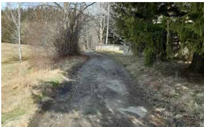
Poslední letošní investicí města do našich osad a celkově do infrastruktury je 800 m 2 nového povrchu komunikace v Korkusově Huti...
