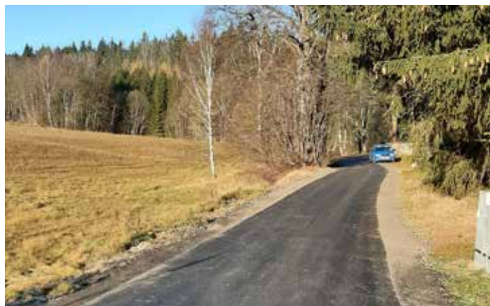
... Tuto stavební akci realizovala v průběhu podzimu společnost VKB stavby, s. r. o.
