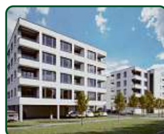
Bytové domy Břeclav, ul. Charvátská
