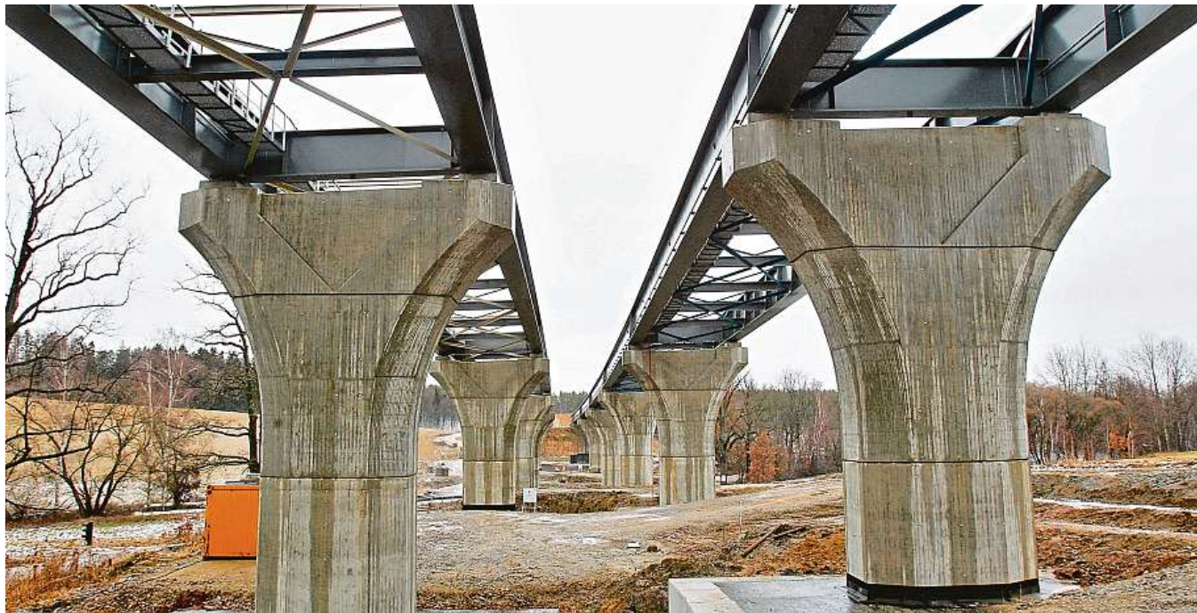
DÁLNIČNÍ MĚNÍ KRAJINU NA JIHU ČECH POKRAČUJE STAVBA D3. PRACUJE SE NA OBCHVATU BUDĚJOVIC I SMĚREM K HRANICÍM S RAKOUSKEM. FOTO: MAFRA
