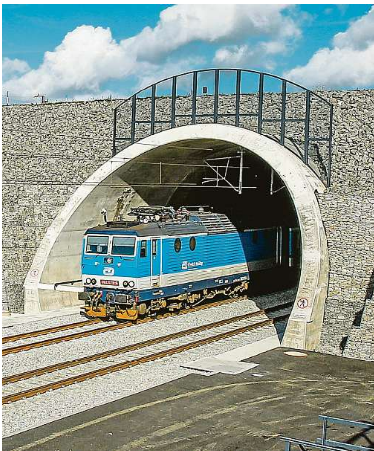
Na IV. železničním koridoru už vlaky jezdí novým tunelem Zvěrotice u Soběslavi. Na snímku je rychlík Vltava z Prahy do Budějovic. FOTO | PETR LUNDAK, MAFRA
