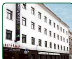
eFi Palace Hotel, Brno, dokončené 2 etapy
