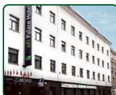
eFi Palace Hotel, Brno, dokončené 2 etapy
