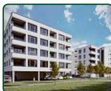
Bytové domy Břeclav, ul. Charvátská
