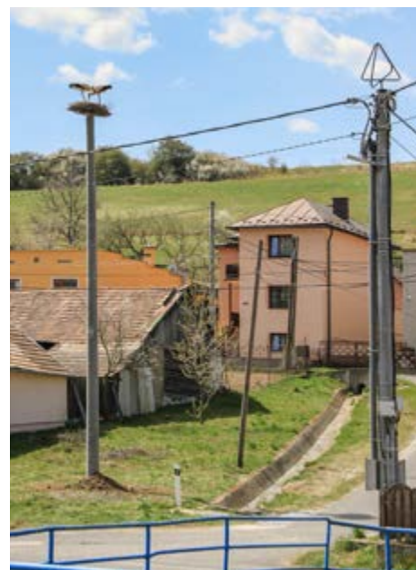
Bociany okamžite prijali novú podložku; vpravo vidíte hniezdnú bariéru na vrchole elektrického stĺpa
