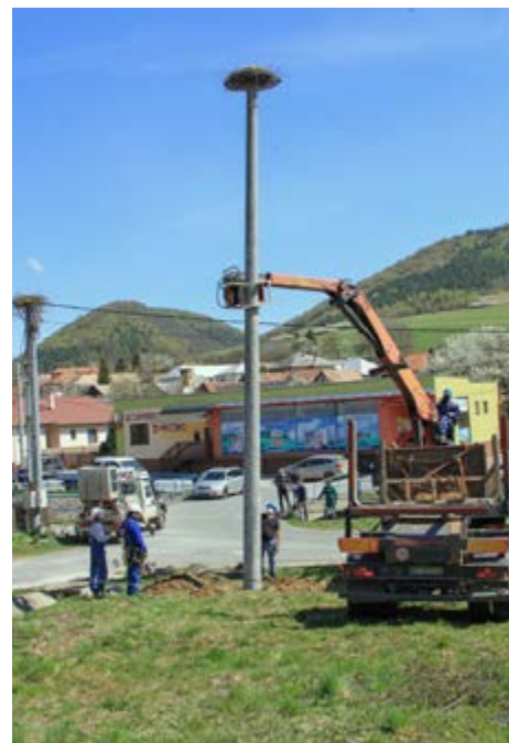
Inštalácia nového stĺpu s hniezdnou podložkou (vpravo) vedľa pôvodného hniezda na elektrickom stĺpe (vľavo), Kluknava, apríl 2020
