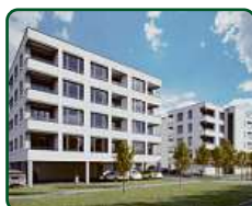
Bytové domy Břeclav, ul. Charvátská
