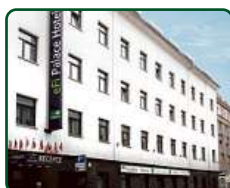
eFi Palace Hotel, Brno, dokončené 2 etapy
