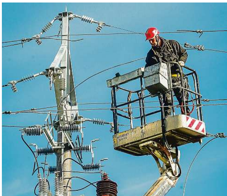
Distribuční společnost EG.D instaluje u Pluhova Ždaru na vodiče vysokého napětí nová zařízení – reclosery.
