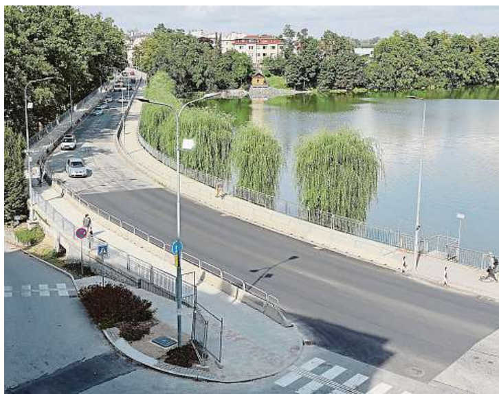
Lávku pro pěší na pravé straně vozovky drží sloupky zapuštěné do hráze nádrže Jordán. Oprava by vyšla zřejmě až na 80 milionů. FOTO | DAVID PELTÁN
