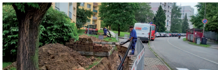
Rekonstrukce teplovodu v České ulici.
