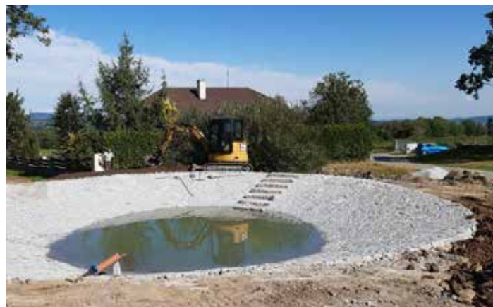
Obnova požární nádrže na Sklářích - více na str. 3.
