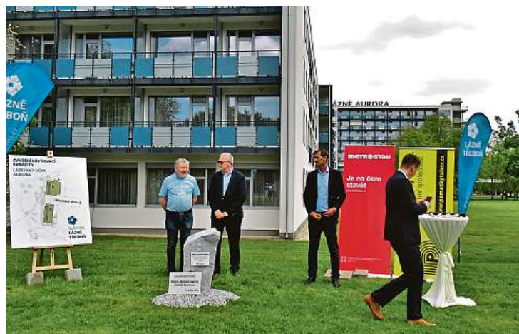
Minulý týden ve středu začala přístavba budovy B Lázní Aurora. K objektu dodělávají dvě boční křídla.
