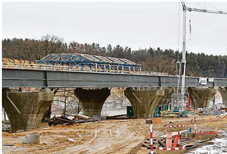
Kvůli chybějícímu materiálu se dopravní stavby na jihu Čech zřejmě zpozdí a také prodraží. Výjimkou není ani dálnice D3. FOTO | PETR LUNDÁK, MAFRA
