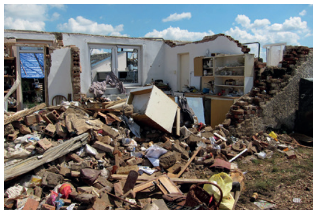
Obr. 9 Zdevastovaný dům v obci Mikulčice po tornádu na jižní Moravě ze dne 25. 6. 2021.
