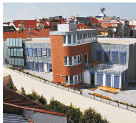
„Ptačí pohled“ na budovu Centra Kosatec.
