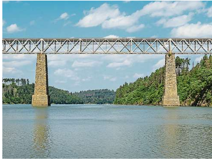
Původní ocelová konstrukce přes Orlík z roku 1889 je již v nevyhovujícím stavu, slouží už přes 130 let.
