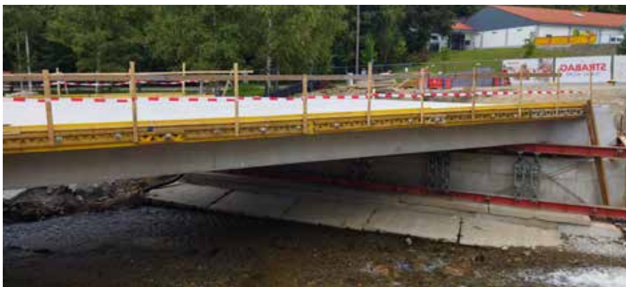
Na začátku prosince by měl být otevřen nový most přes Volyňku.
