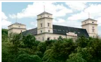
Zámek Račice, přestavba
