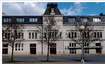
Multifunkční budova, Brno
