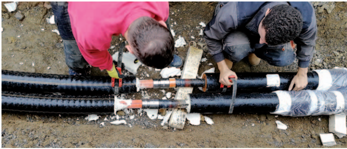
Napojení nového plastového potrubí k budově Komerční banky.
