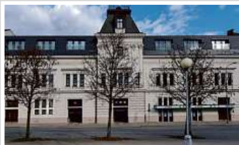
Multifunkční budova, Brno
