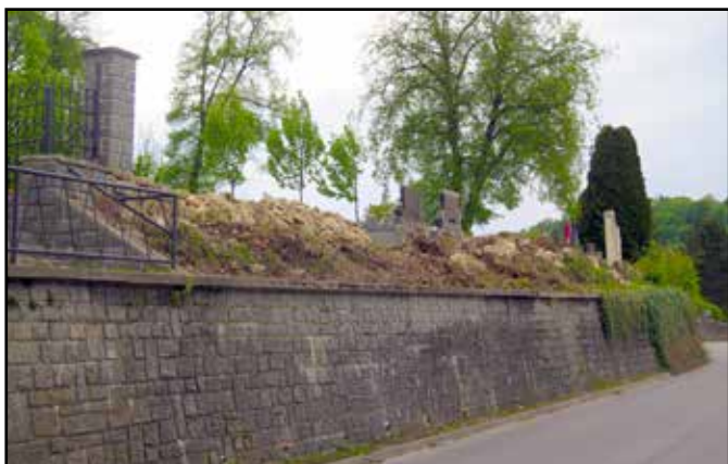
Po vykácení stromů je jiný pohled na hřbitovní zeď.
