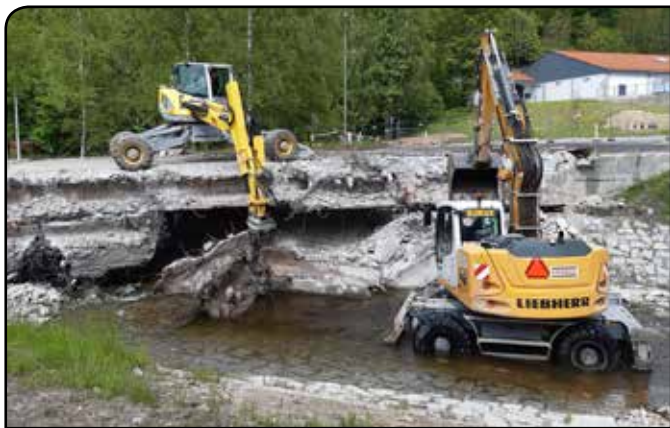
Demolice mostu přes Volyňku.
