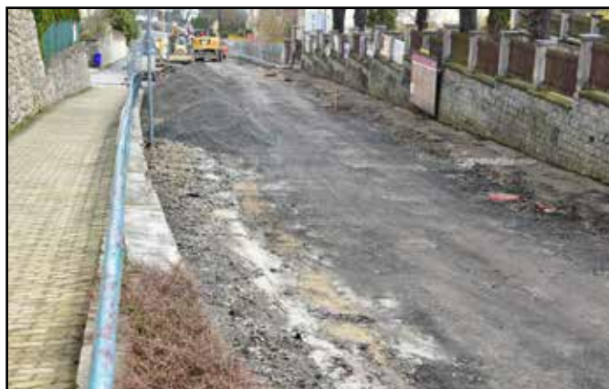
Rekonstrukce ulice 1. máje.
