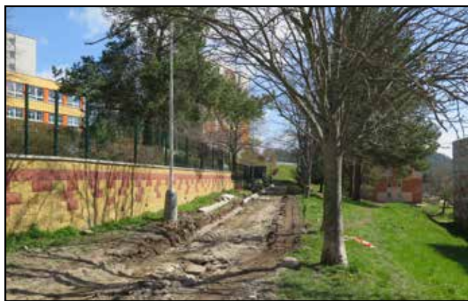
Rekonstrukce chodníku na sídlišti.
