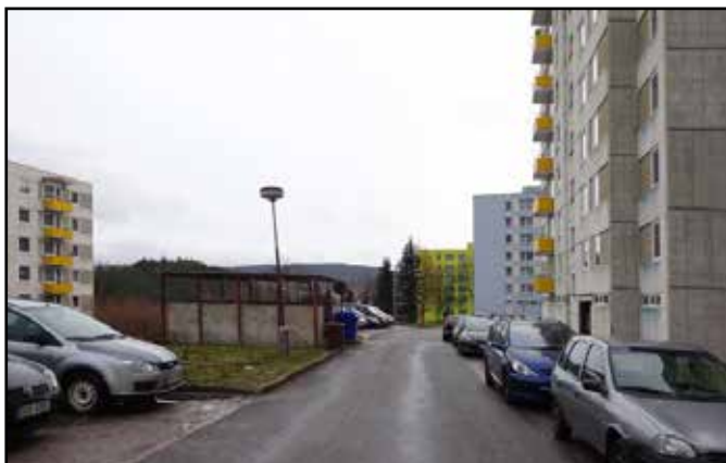
Ulice Luční – současný stav...
