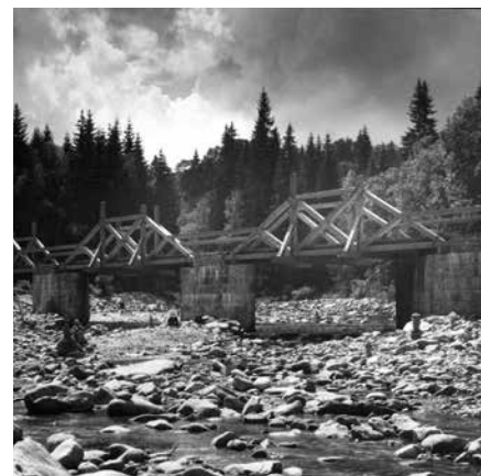
Nově postavený hradlový most u Modravy
